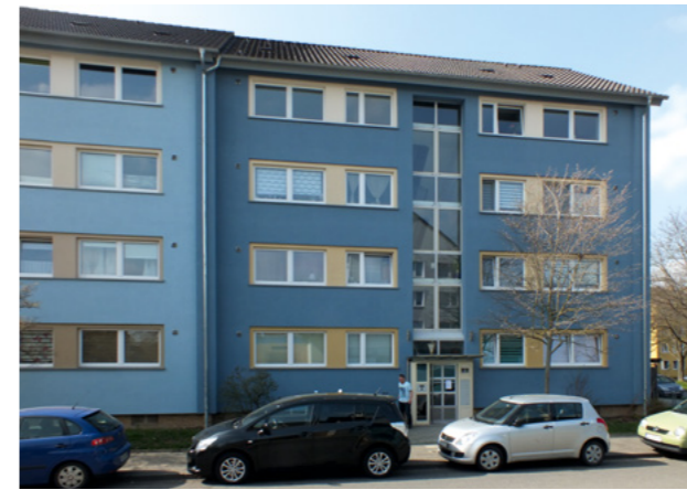
In der Ehrlicherstraße und auch entlang der Hermann-Seeland-Straße 20 - 26 (unten) wurde eine energetische Sanierung bereits durchgeführt.
