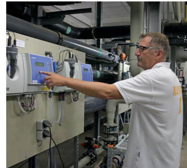
Schwimmeister Gerald Wendt beim Kontrollblick auf den Chlorgehalt der verschiedenen Wasserbecken. 2 Millionen Liter fasst allein das Schwimmbecken. Prinzipiell wird es alle fünf Stunden komplett gefiltert.
