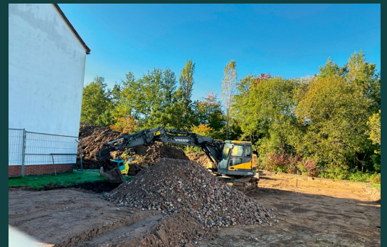
Bevor die Tiefbauarbeiten in der Lübecker Straße beginnen konnten, musste im Herbst zunächst eine Baustraße auf dem Grundstück angelegt werden.
