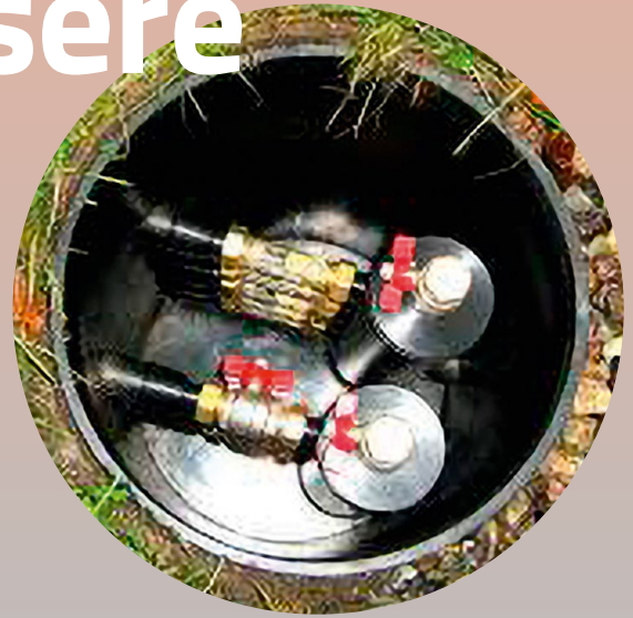
Erdwärme: Kleines Loch – große Wirkung.
