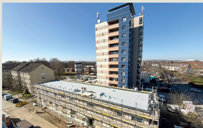
Blick vom Dach des neuen Stadtteilzentrums auf die zukünftige Rossmann-Filiale
